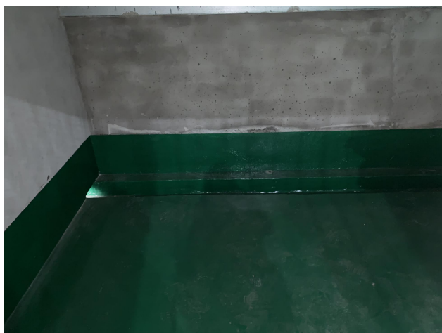
防渗措施: HDPE 膜+混凝土+环氧树脂
