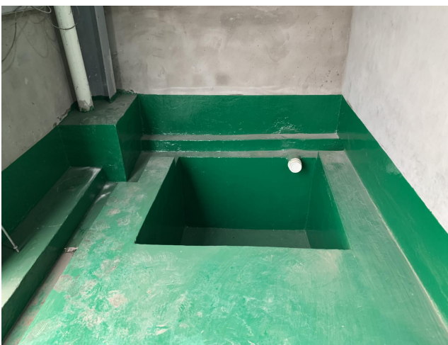
防渗措施: HDPE 膜+混凝土+环氧树脂
