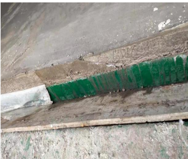
项目防渗措施
