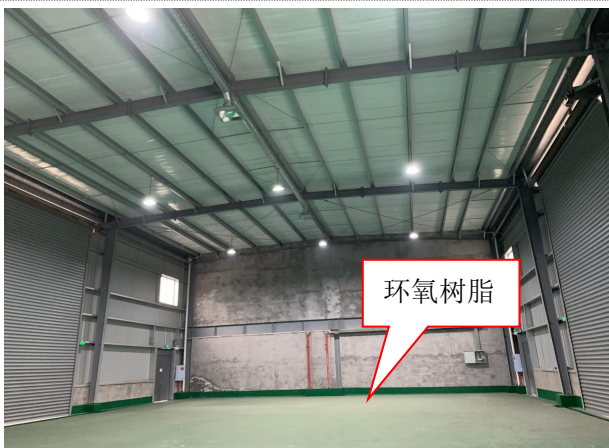
防渗措施: HDPE 膜+混凝土+环氧树脂
