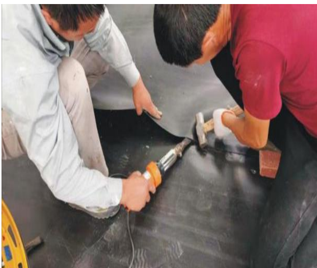
防渗措施施工过程
