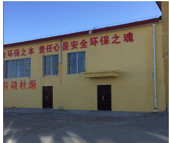
维修后的精炼车间
